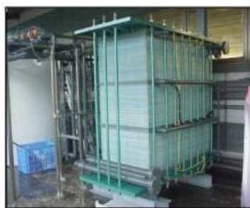
RO濃縮水脫鹽回收 (300 m 3 /d)
