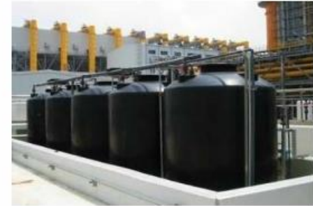
建議回收設備-儲水裝置
