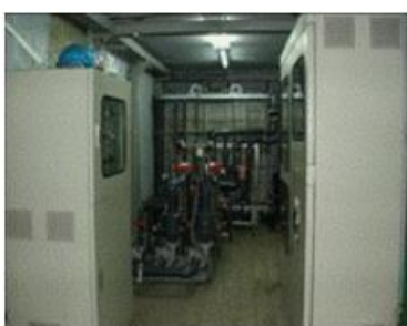
虎生電子冷卻水回收 (550 m 3 /d)
