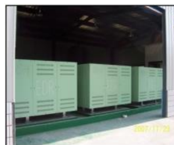
精密螺絲製造業廢水 脫鹽回收 (350 m 3 /d)
