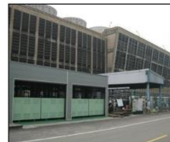
鋼品直接冷卻水回收 (550 m 3 /d)
