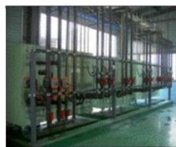
工程螺絲製造廢水脫鹽 回收 (450 m 3 /d)
